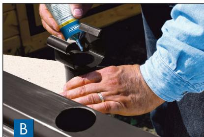
**B** Pulisca l'interno e l'esterno della grondaia nell'area da incollare con il detergente per grondaie Marley. Quindi applichi la colla all'interno della grondaia.
