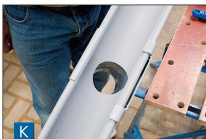
Limare i bordi del foro per pulirli, fissare il beccuccio della grondaia sul bordo posteriore della grondaia e agganciarlo al labbro anteriore.
