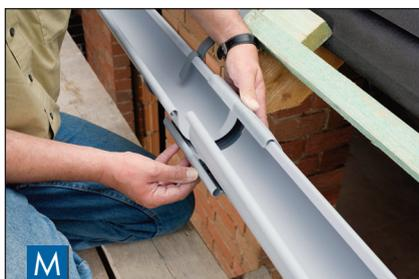
Il manicotto di collegamento viene appeso al bordo posteriore e agganciato al labbro anteriore. Osservi le marcature - sistema a scanalatura e linguetta!
