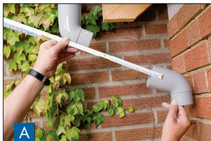
**A** Collochiate una curva sulla bocca di erogazione e misurate la distanza dalla controcurva. Considerate la profondità di inserimento di 4 cm e la distanza dalla parete della casa. In caso di grondaie strette, 2 curve sono collegate direttamente con il raccordo della curva.
