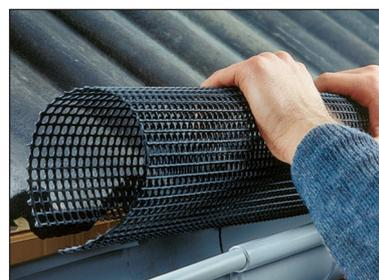
Il tubo grigliato Poly-Net Leaf-Stop viene posizionato all'interno della grondaia e viene tenuto in posizione dalla sua stessa tensione. Facile da installare, il Poly-Net Leaf-Stop di Marley è disponibile in lunghezze di 2 m.
