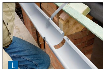
Le grondaie sono collegate da un manicotto di connessione. La distanza corretta dei bordi della grondaia è determinata dai segni sul manicotto di collegamento. Importante: se la grondaia è stata accorciata, la scanalatura deve essere levigata.
