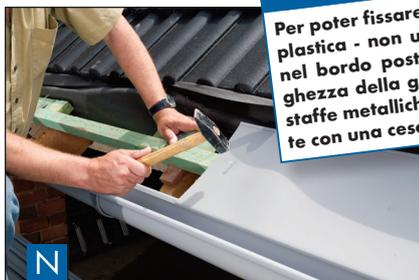
Le strisce di gronda forniscono un'ulteriore protezione dall'acqua piovana e dalla neve che scivola. Vengono fissate nel bordo della grondaia e fissate con chiodi a strappo al listello del tetto ogni 30 cm. Le strisce di gronda sono installate con una sovrapposizione di almeno 4 cm.
