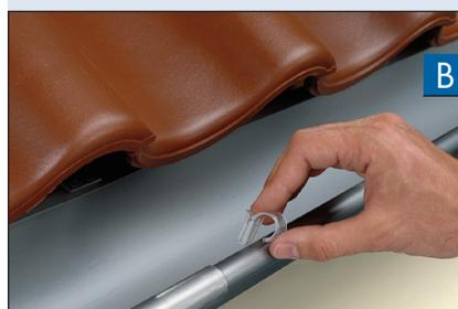
Le clip di fissaggio vengono spinte sul labbro anteriore della grondaia con una distanza di circa 40 cm.
