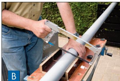
**B** I pluviali Marley possono essere facilmente tagliati con una sega a denti sottili. Suggerimento: Per ottenere un taglio rettilineo, utilizzate una scatola per curve oblique.
