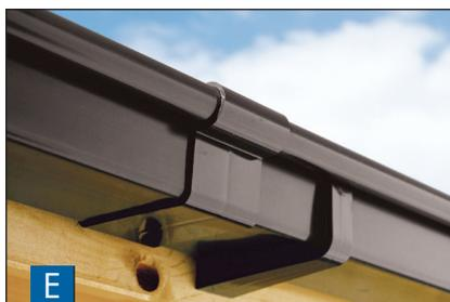
**E** Quando collega due estremità di grondaia, deve usare un manicotto di collegamento. Applichi la colla all'interno del manicotto di collegamento e spinga le estremità della grondaia nel manicotto stesso.
