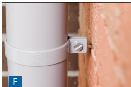
**F** Quando si utilizzano morsetti fissi, il pluviale viene fissato all'estremità superiore. Viene montato solo il bullone ad occhiello tra le piastre del morsetto per tubi. Il tubo di discesa può quindi essere fissato saldamente in questo punto. Distanza tra i morsetti: 2 - 2,50 m.
