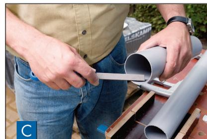
**C** Limare le estremità tagliate del pluviale in modo pulito; soprattutto se installate un collettore di pioggia Marley, questo può migliorare notevolmente la capacità di raccolta.
